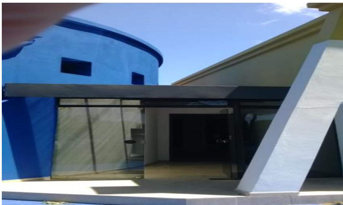
Entrada de acceso lateral habilitado en el marco del mantenimiento en el 2013 y 2018
